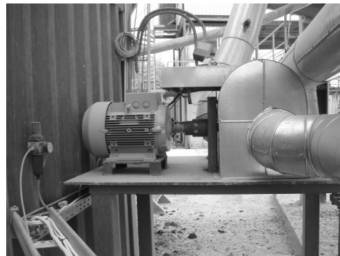
2 pav. Nuo 2007 metų veikiančios modernizuotos BDS siurblio mazgas
